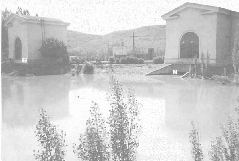
Рис. 4.17. Сооружения на пересечениях. Туннель на магистральном канале. Канал туннелем пересекает водораздел
