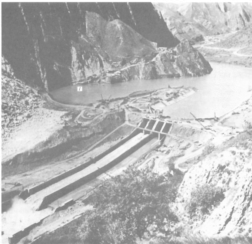
Рис. 4.14. Плотинный береговой туннельный водозабор. Сброс воды осуществляется через туннель (1), начинающийся от берега водохранилища
