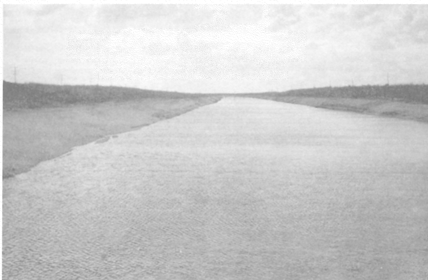
Рис. 4.9. Обводнительно-оросительный канал в земляном русле. На отдельных участках имеются противифльтрационные покрытия из полиэтиленовой пленки и защитного слоя уплотненного грунта
