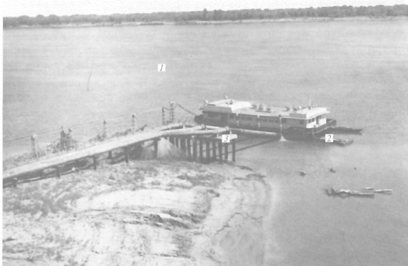
Рис. 4.16. Водозабор с механическим водоподъемом. Плавучая насосная станция (головная). На снимке видны: 1 – подводный канал (залив) из водохранилища; 2 – понтон; 3 – напорный трубопровод
