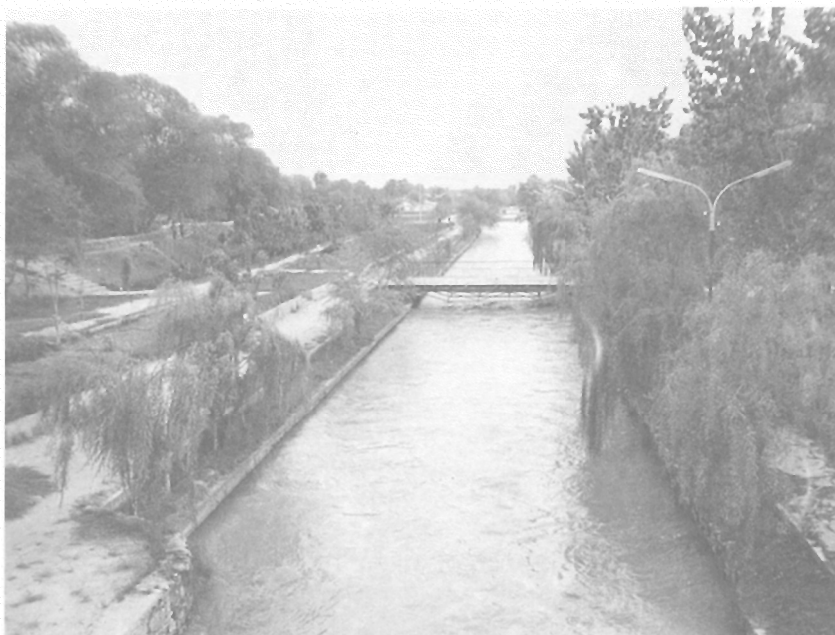
Рис. 4.8. Межхозяйственный оросительный канал в земляном русле, облицован в пределах населенного пункта
