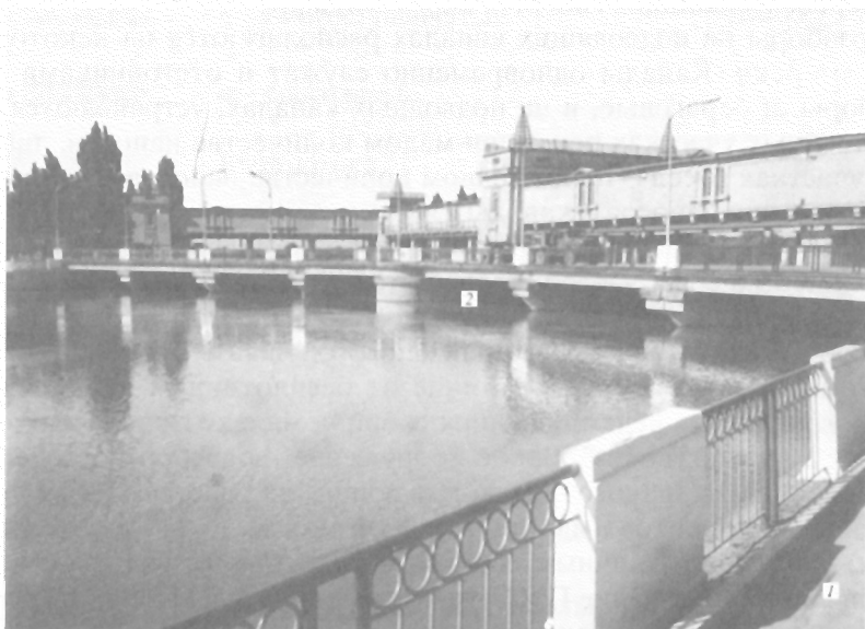
Рис. 4.13. Головное водозаборное сооружение 1 – низконапорная водосбросная плотина; 2 – шлюз-регулятор
