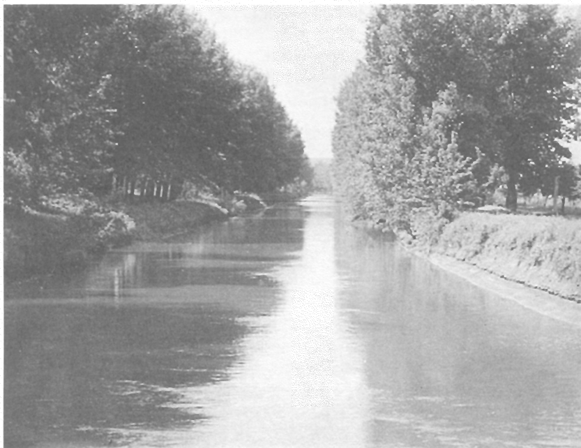
Рис. 4.6. Магистральный канал в земляном русле
